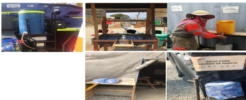
Material disponible en obra para lavado de manos/Gel antibacterial/agua potable
