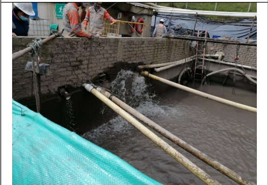
Fotografía 18 PTARnD (Coordenadas planas origen único E5040132.02, N2374839.89)
