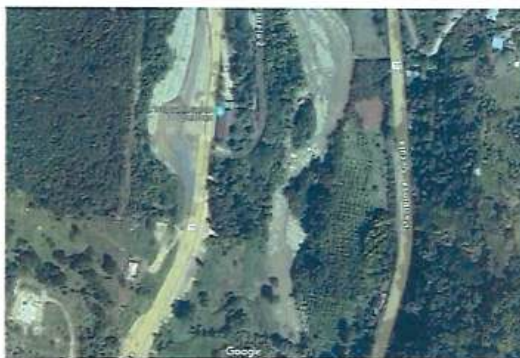
VISTA DEL PREDIO EN GOOGLE
