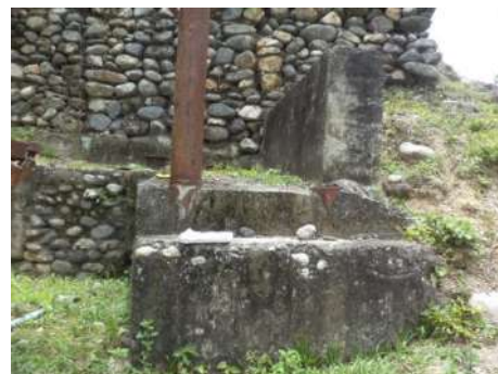
CA6 MUROS CONCRETO CICLOPEO
