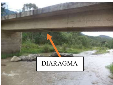
CA31 PUENTE NUEVO
