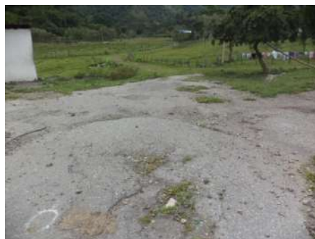
CA8 ZONA DURA - PAVIMENTO
