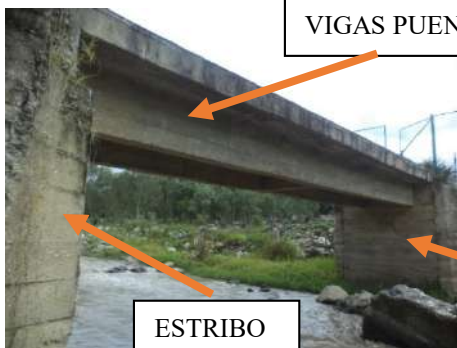
CA31 PUENTE NUEVO
