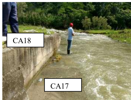
CA17- CA18 MURO CONCRETO CICLOPEO
