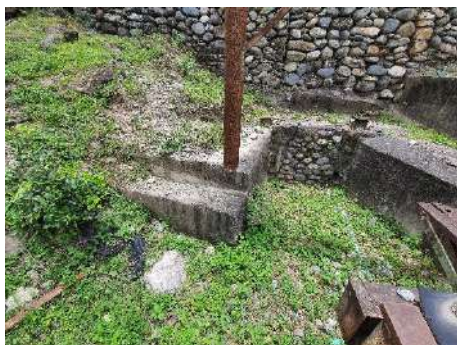
CA6 MUROS CONCRETO CICLOPEO
