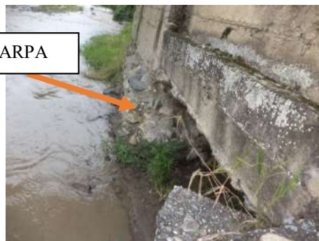
CA31 PUENTE NUEVO
