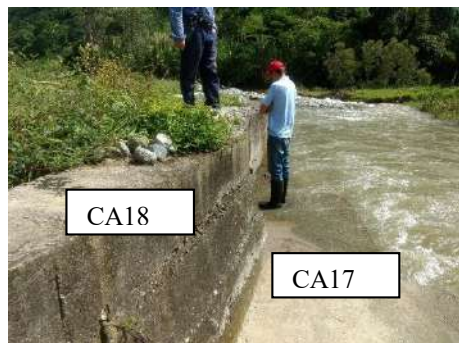
CA17- CA18 MURO CONCRETO CICLOPEO
