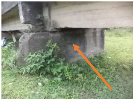
CA25 BASE DE LA VIGA PUENTE
