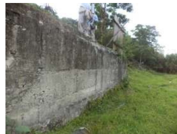
CA1 MURO CONCRETO CICLOPEO
