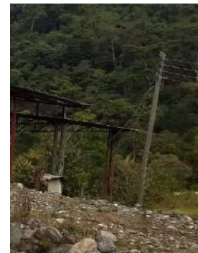
CA44 POSTE MADERA
