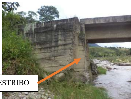
CA31 PUENTE NUEVO
