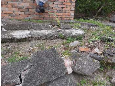
CA2 MURO Y PISO
