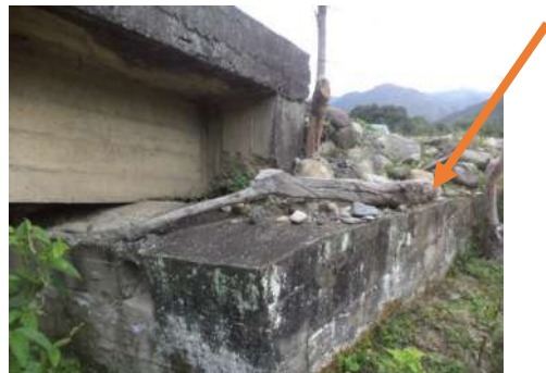
CA26 MURO LATERAL
